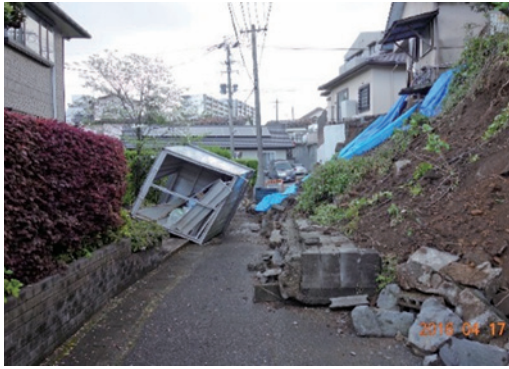
写真 1. 地震後翌日の石垣の崩落と土砂
