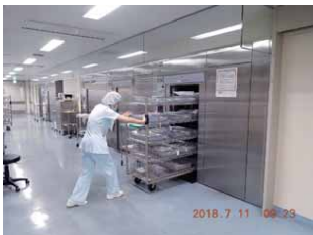
3) 酸化エチレンガス滅菌装置2台、277回/年(+23)
