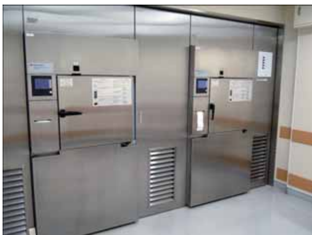
4) 過酸化水素低温ガスプラズマ滅菌装置2台 1,023回/年(+46)
