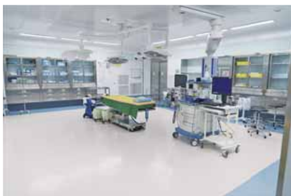
【令和 2 年に稼働開始した 15 号室】
