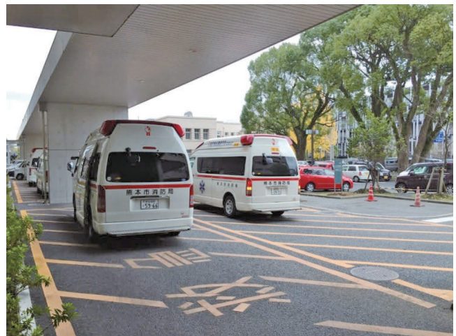
【救急車搬入口】
