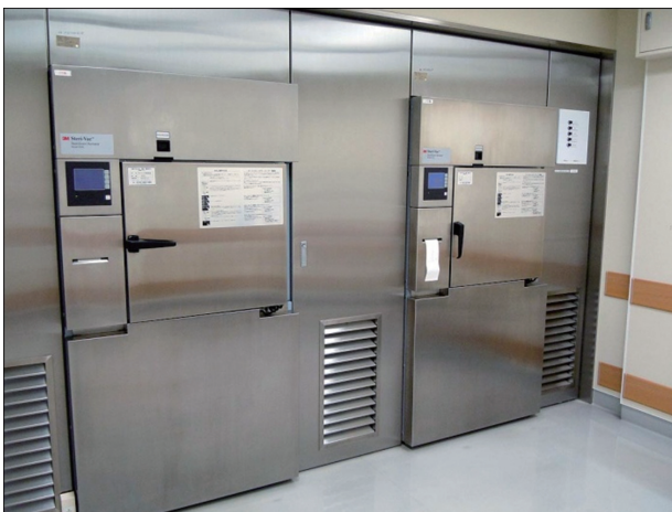
3) 酸化エチレンガス滅菌装置2台、254回/年間
